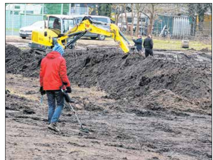
Baustart: Der Mutterboden wird derzeit abgeschoben. Die Arbeiten werden archäologisch begleitet. Foto: Marco Winkler
